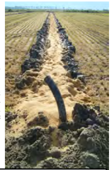
敷設完了の先端。後端は150m先の排水路
