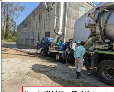
生コン車到着。打設スタート
