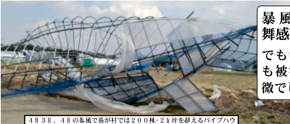
4月3日、4日の暴風で我が村では200棟・2万坪を超えるパイプハウスが根こそぎ倒壊。骨組みまでグチャグチャ。
