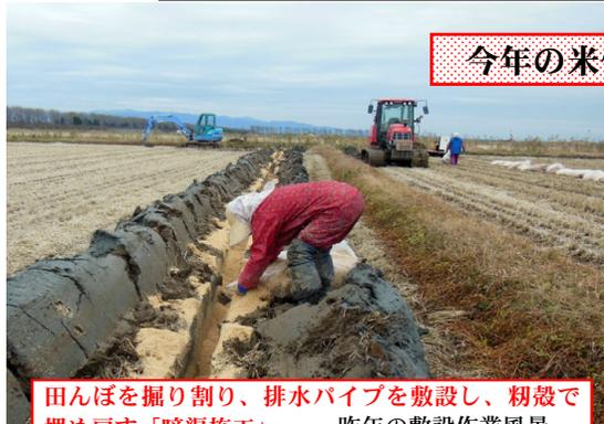
田んぼを掘り割り、排水パイプを敷設し、籾殻で埋め戻す「暗渠施工」 一昨年の敷設作業風景
